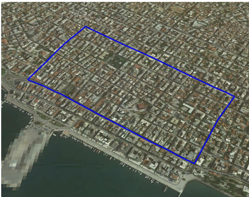
Εικόνα 6: Περιοχή νέων πεζοδρόμων.
